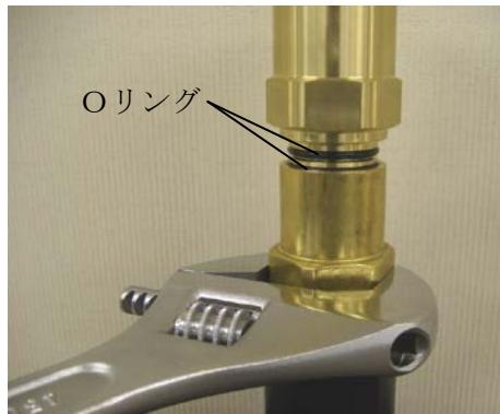
なお、内封ガスの大気への放出は、通常は数秒で終了しますが、希に止まりが悪い場合があります。これは、連結弁の気密性が弁のバルク貯槽側と安全弁側との圧力差に影響されるため、止まりが悪い要因は、弁の完全な閉止に必要な圧力差が得られていないためです。
